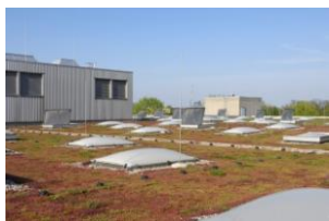
Bereits vor über 10 Jahren wurde die Dachfläche des Gebäudes 5.0 begrünt. In den Sommermonaten verringert die Begrünung den Temperaturanstieg im Fertigungsgebäude.
