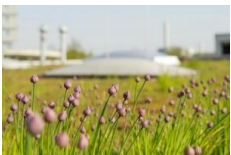
Bereits vor über 10 Jahren wurde die Dachfläche des Gebäudes 5.0 begrünt. In den Sommermonaten verringert die Begrünung den Temperaturanstieg im Fertigungsgebäude.
