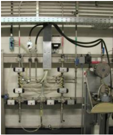
Durch die Molchtechnik erfolgt eine effektive und effiziente Reinigung der Rohrleitungen. Dies spart Reinigungsmittel und Zeit.
